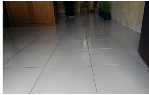
Lantai SDN 15/V mengalami penurunan tanah
